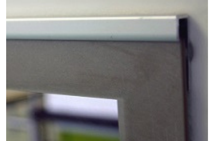
J-listan profiili; Peili tulee seinästä irti 4 mm peilillä n. 9 mm, j-listaa tulee peilin päälle n. 10 mm.
